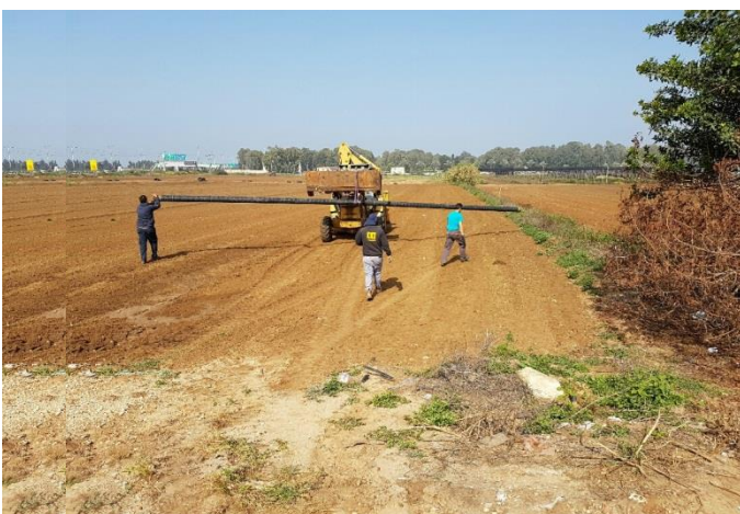
הנחת קו מים לחקלאות ברחוב השרף
