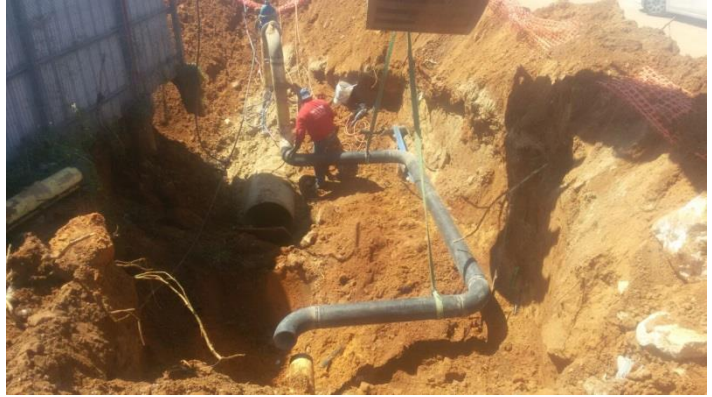
הסתת קו מים לטובת החלפת קו ביוב למט"ש
