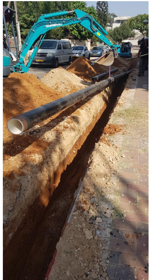
החלפת קו מים ברחוב השומר
